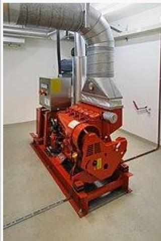
Motor a diesel, em aplicação estacionária, acoplado a um gerador.
