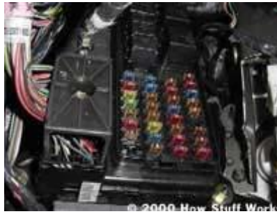
Painel de fusíveis no interior
