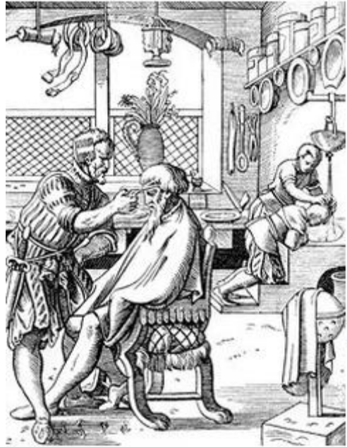
Local onde os barbeiros trabalhavam
