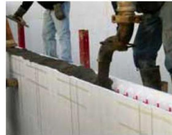
Fôrmas de EPS são leves, o que torna a montagem mais rápida. Após a concretagem, elas passam a fazer parte da construção
