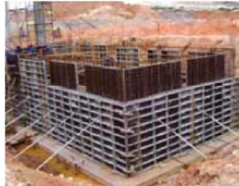
**Aplicações:** grandes estruturas de concreto, pilares, paredes, concreto aparente, fôrmas trepantes com andaime acoplado, barragens e poços de elevadores
