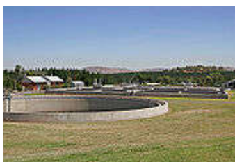
Foto de uma estação de tratamento de águas residuais (ETAR)
