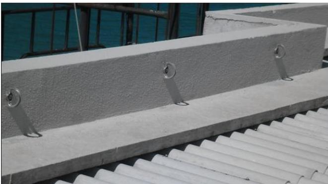
No caso de obras provisórias ou em taludes com auxílio de atividade de acesso por corda ou atividade em corda dupla, criamos recursos especiais seja fincando qualquer elemento estrutural que conhecemos a resistência do material a fim de suportar o peso do sistema somado aos equipamentos e do próprio funcionário.
