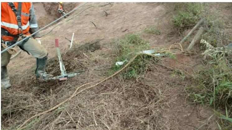
Os pontos de ancoragem devem ser constituídos por materiais resistentes a intempéries, não provocar esforços cortantes nas cortas, não causar abrasões e resistir a esforços de tração de 1.500 a 3.000 kgf, dependendo da situação específica de cada atividade e do projeto a ser executada pode ser alterada para mais ou para menos, dependendo da situação e do projeto.
