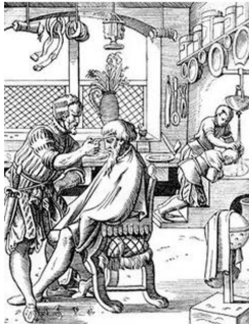
Local onde os barbeiros trabalhavam
