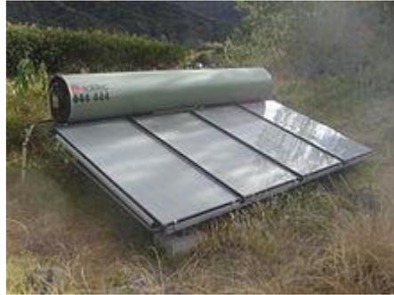
Um sistema de aquecimento solar composto por quatro coletores e um boiler.
