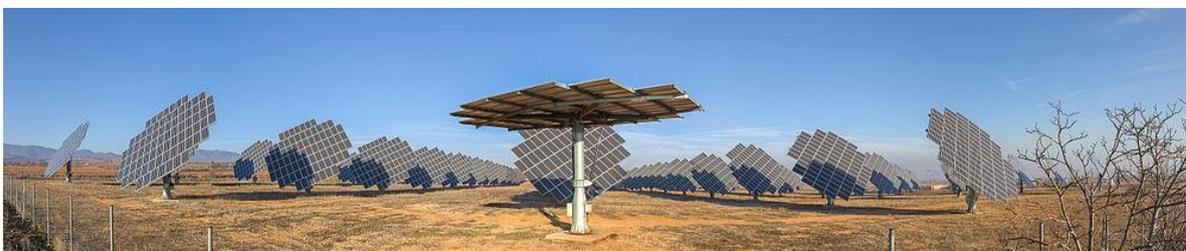
Estação solar fotovoltaica de Cariñena, província de Saragoça, Espanha. Os painéis são montados em dispositivos de rastreo de duplo eixo para maximizar a intensidade da radiação incidente. Esta solução permite que os painéis acompanhem o sol durante sua órbita diurna.
