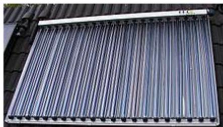
Coletor solar a vácuo em corte. Note que os tubos é que possuem a camada absorvedora, e no lugar da placa absorvedora do modelo comum há neste uma placa refletora.
