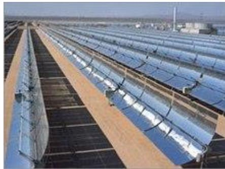
Usina heliotérmica a base de calhas cilindro-parabólicas.
