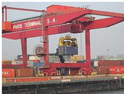
Grua para movimentação de containers no porto de Gennevilliers, perto de Paris
