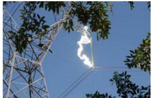
No caso de falhas elétricas ou curto circuito é um fenômeno indesejável que libera uma enorme quantidade de calor. Este fenômeno, além da liberação de calor, liberam partículas de metais ionizadas que eventualmente podem conduzir correntes, deslocamento de ar com aparecimento de alta pressão, prejudicial ao sistema auditivo, e raios ultravioletas prejudiciais a visão.
