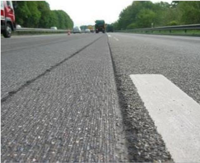
Aplicação com microfresagem (à esquerda)
