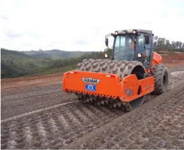
Compactação do solo melhorado após a passada da recicladora e antes da passada da motoniveladora
