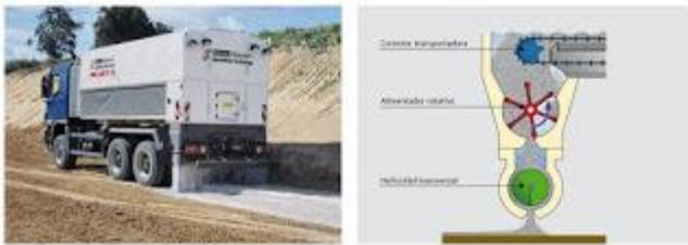
Espargidor/distribuidor em operação aplicando cal sobre um solo..
