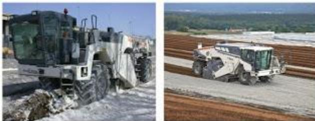
Estabilização de solos com adição de cal (esquerda) e cimento (direita).
