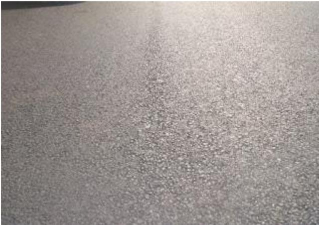
Segregação asfáltica na capa de rolamento após a aplicação do material pela pavimentadora de asfalto.
